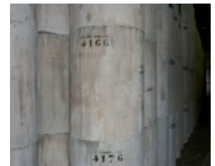
Coques béton de boues et concentrats
