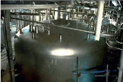
Cuve en acier inoxydable contenant les solutions molybdiques de produits de fission
