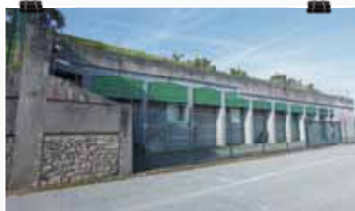
1. Bâtiment des bassins situé au nord-ouest du site.
