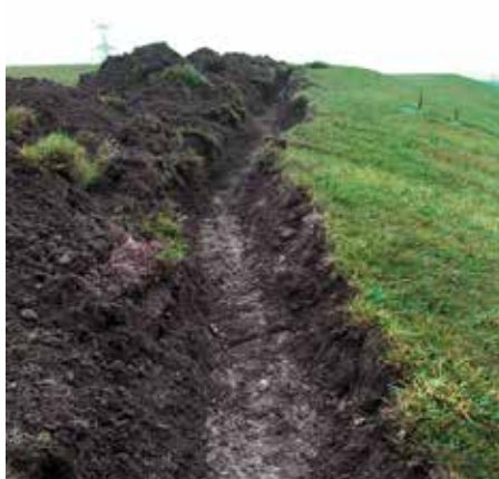
Décapage de la terre végétale.
