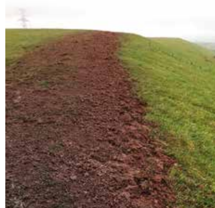
Remise en place de la terre végétale.
