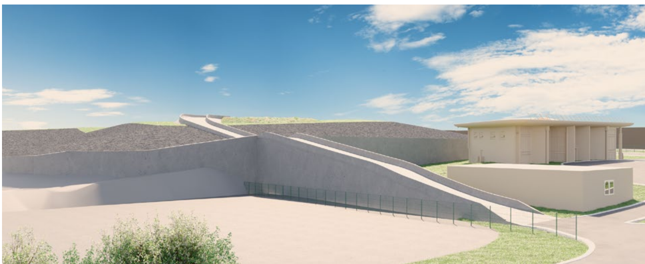
Nouvelle rampe d'accès au toit de la couverture / solution d'étanchéité dite « béton bitumineux étanche »
