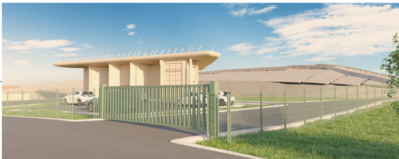
Entrée du CSM / solution d'étanchéité dite « Mégatuiles »
