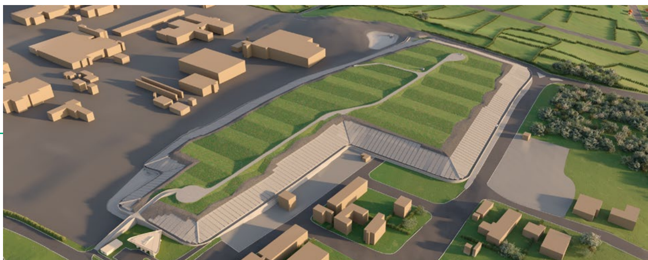
Vue aérienne du CSM / solution d'étanchéité dite « Mégatuiles »
