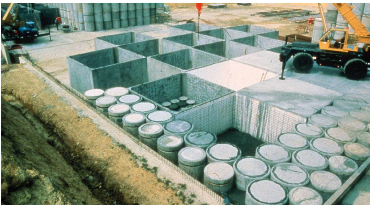
Ouvrage de stockage en monolithe en cours de remplissage
