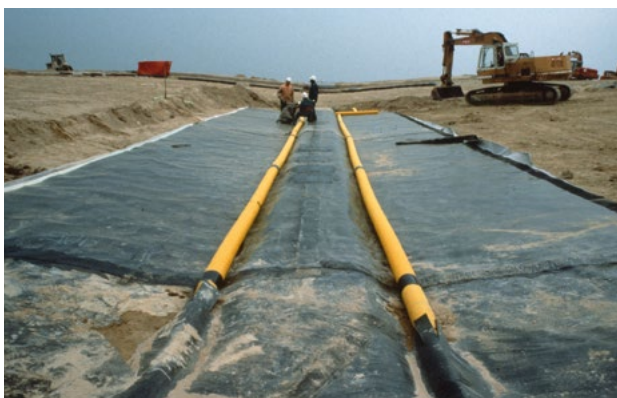
Pose de drains lors de la mise en place de la couverture
