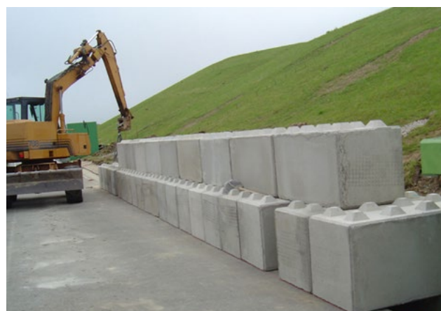
Mur de confortement de la couverture
