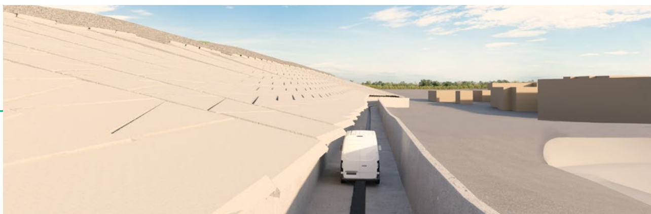
Nouveau canal-route / solution d'étanchéité dite « Mégatuiles »
