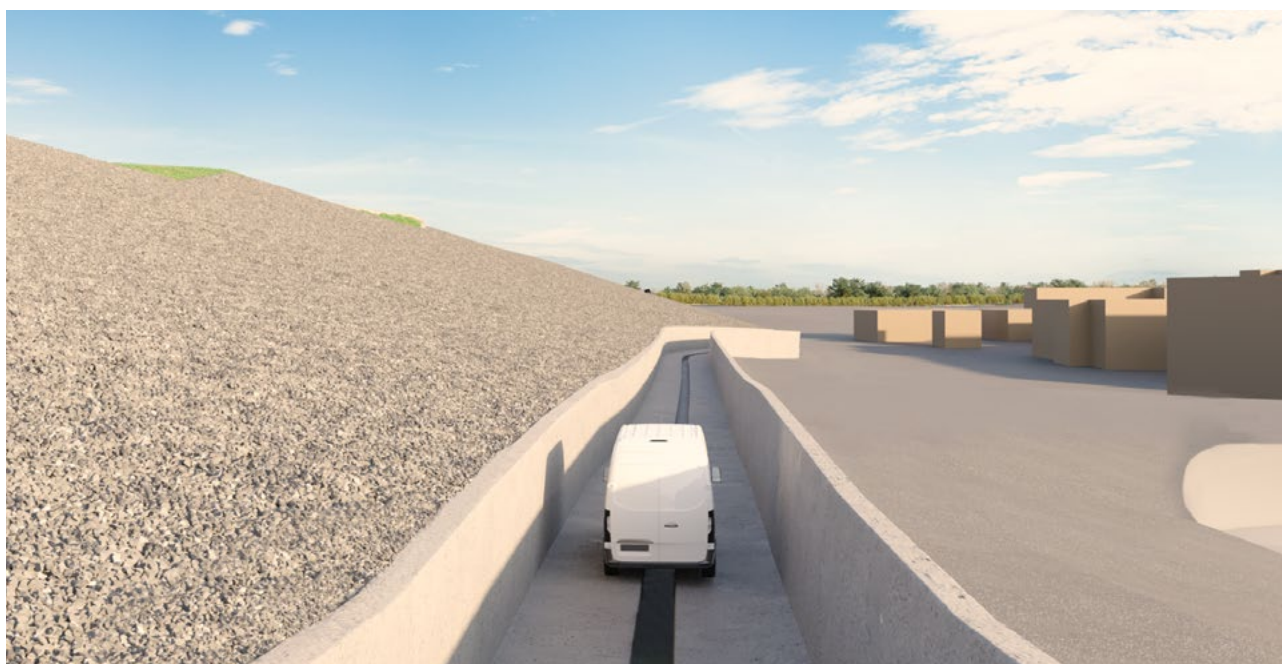
Vue du canal-route périphérique avec la solution dite « béton bitumineux étanche »
