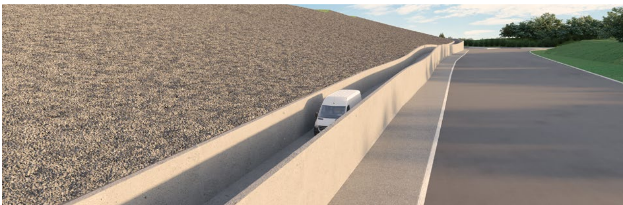
Nouveau canal-route / solution d'étanchéité dite « béton bitumineux étanche »
