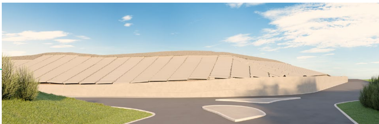
Arrivée par le Nord-est / solution d'étanchéité dite « Mégatuiles »
