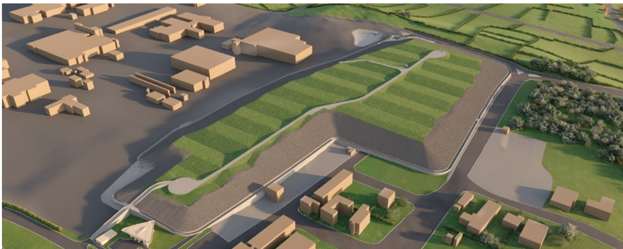
Vue aérienne du CSM / solution d'étanchéité dite « béton bitumineux étanche »
