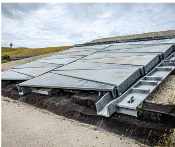
Essai de pose de mégatuiles
