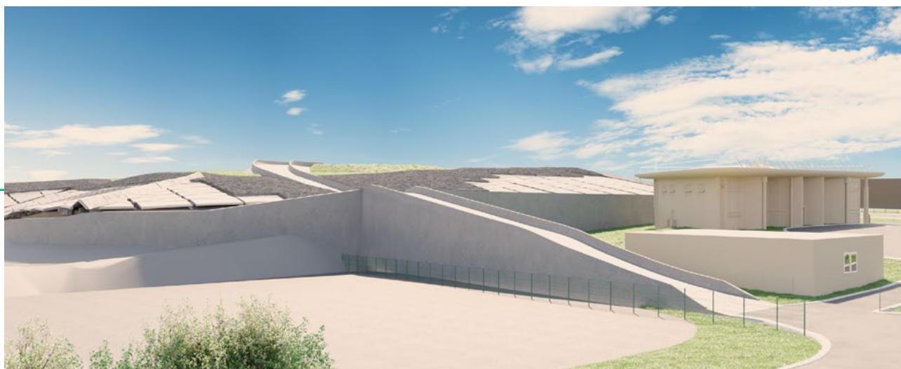
Nouvelle rampe d'accès au toit de la couverture / solution d'étanchéité dite « Mégatuiles »
