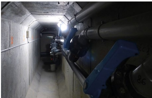
Réseau séparatif gravitaire enterré
