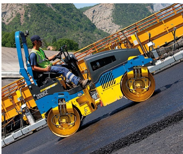
Exemple d'application de béton bitumineux
