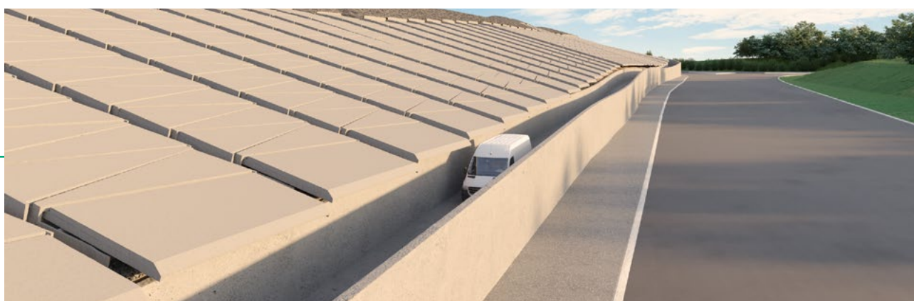
Nouveau canal-route / solution d'étanchéité dite « Mégatuiles »
