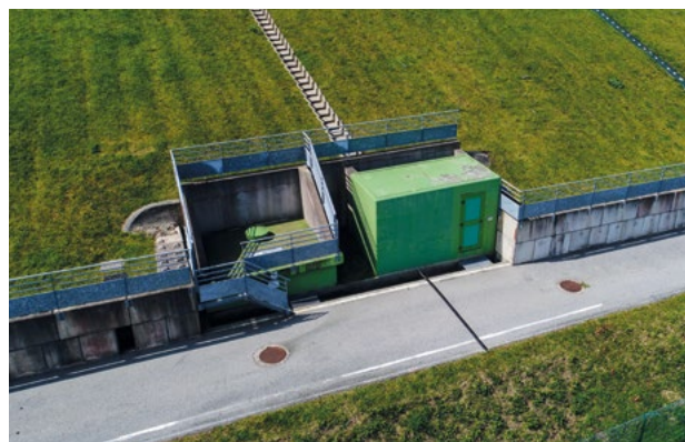
Chambre de drainage et pluviale
