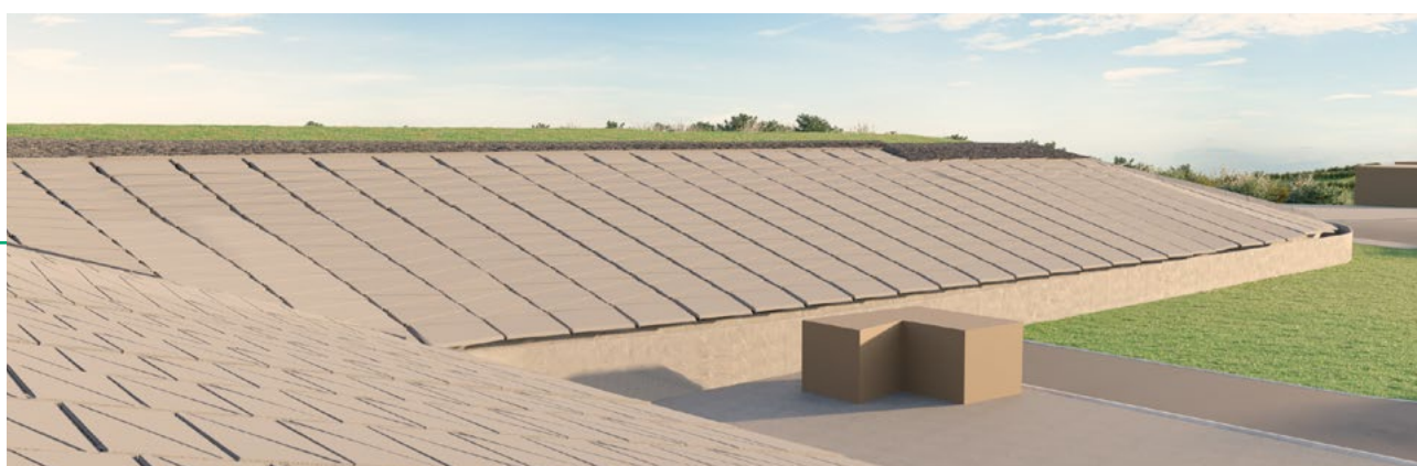
Pentes adoucies / solution d'étanchéité dite « Mégatuiles »
