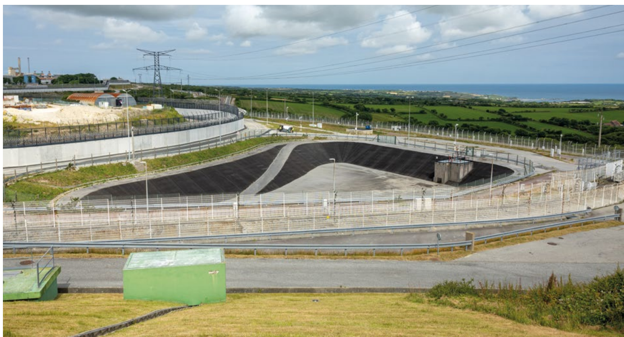
Bassin d'orage pour les eaux de pluie et les eaux issues du drainage de la couverture
