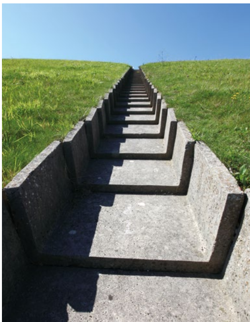
Descente d'eau vers le caniveau pluvial
